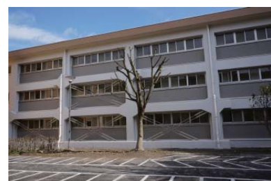
寄宿舎B棟耐震改修 (H24)
