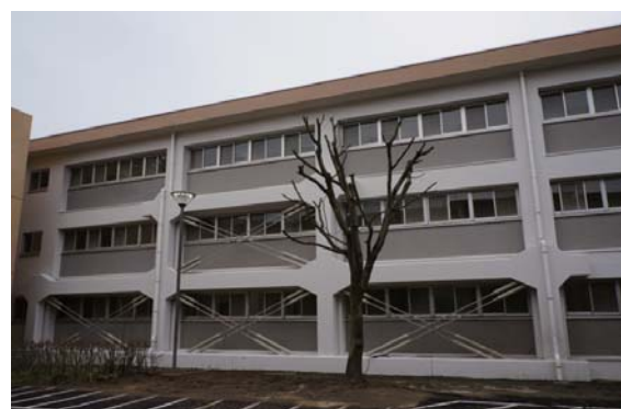
建物耐震改修
