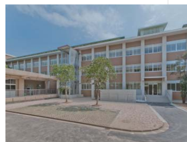
校舎棟耐震改修 (H24)
