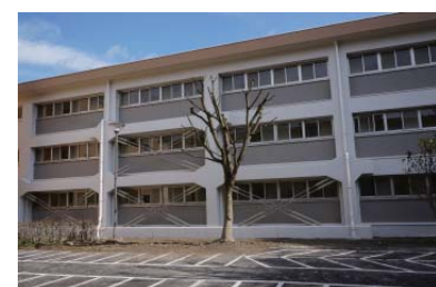
寄宿舍B棟耐震改修 (H24)
