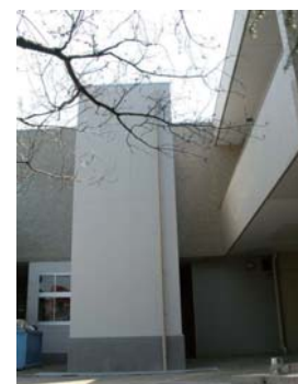
図書館エレベータ取設 (H21)
