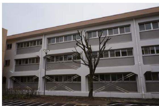
建物耐震改修
