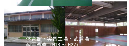
実習工場改修 (H19～H21)
