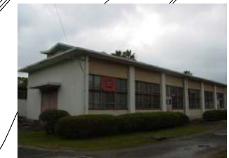
機械工学科A棟 (昭和47年)
