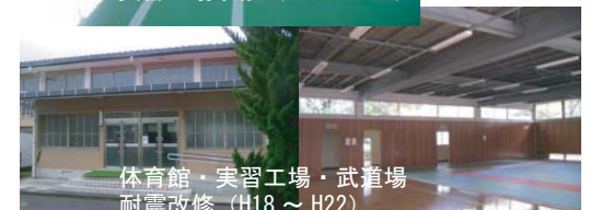
実習工場改修 (H19～H21)
