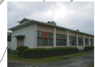
機械工学科A棟（昭和47年）
