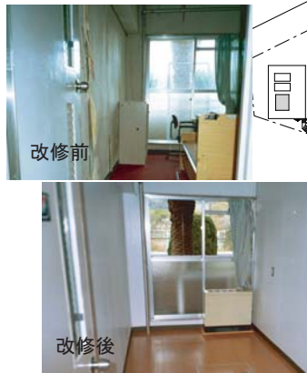
改修前 改修後 寄宿舍寮室等模様替 (H18～H21)
